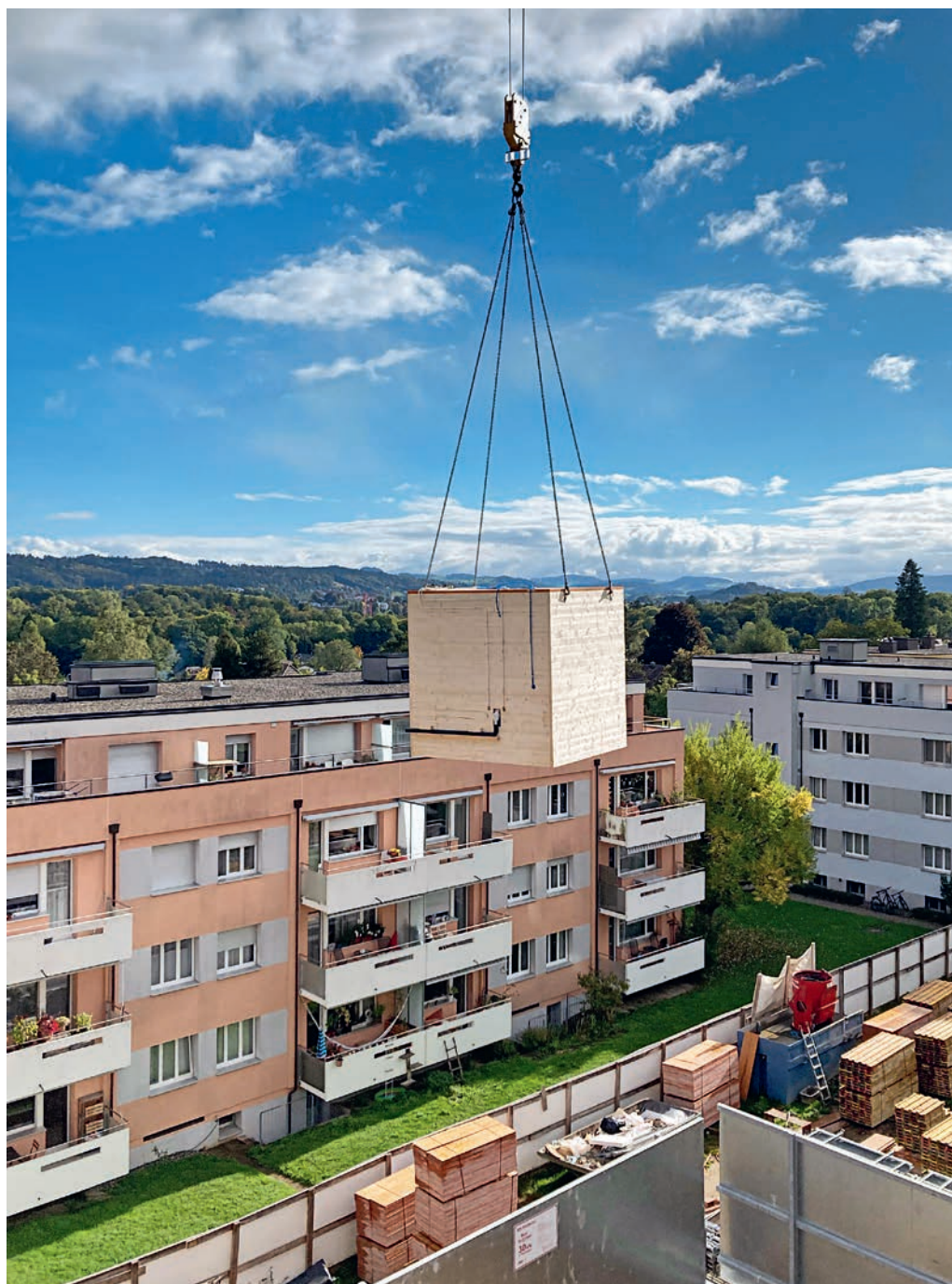
Das vorgefertigte Badmodul wird mit dem Kran in das sich im Bau befindende Gebäude eingesetzt.
