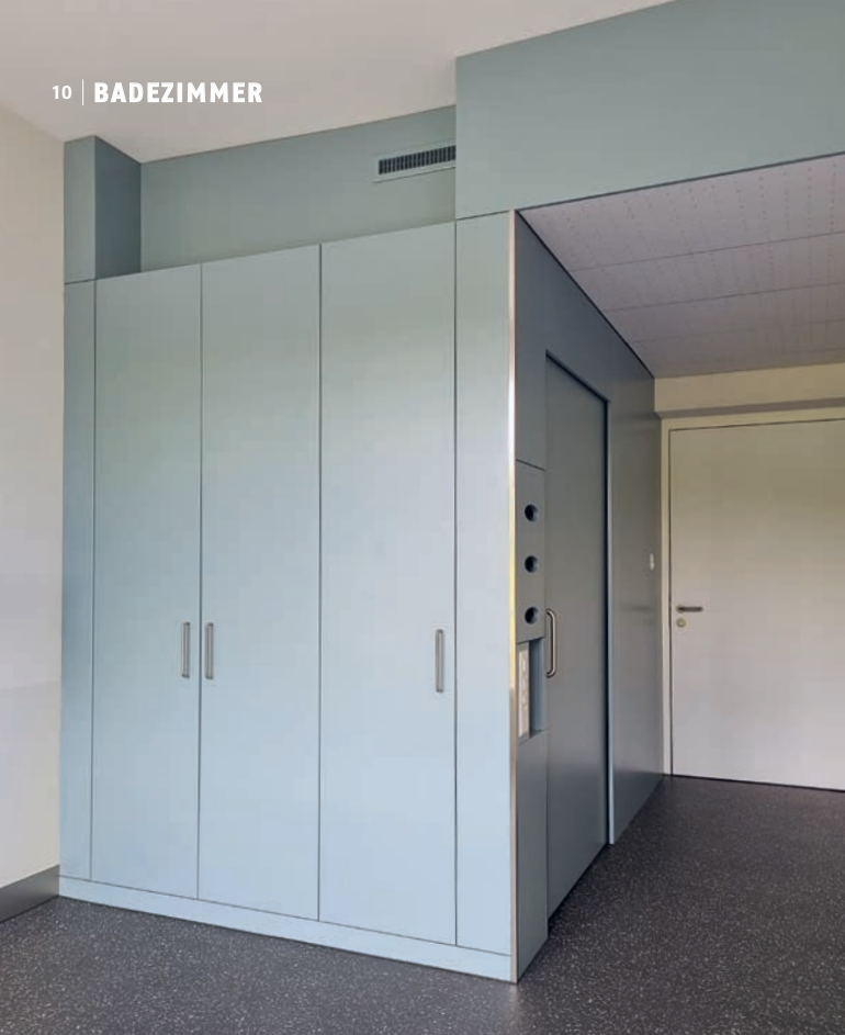
Fertig eingebaute Muota-Fertignasszelle im Spital Zollikerberg in der Gemeinde Zollikon ZH.
